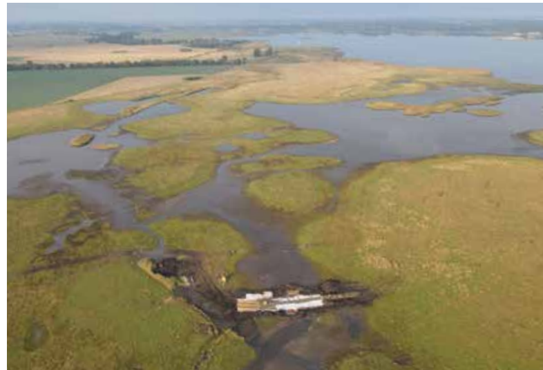
___ Abb. 3: Bau von Furten im Nordteil der Karrendorfer Wiesen, um die Querung der Priele durch Rinder zu erleichtern und damit die Beweidung der Salzwiesen zu verbessern. Foto: Philip Riel
