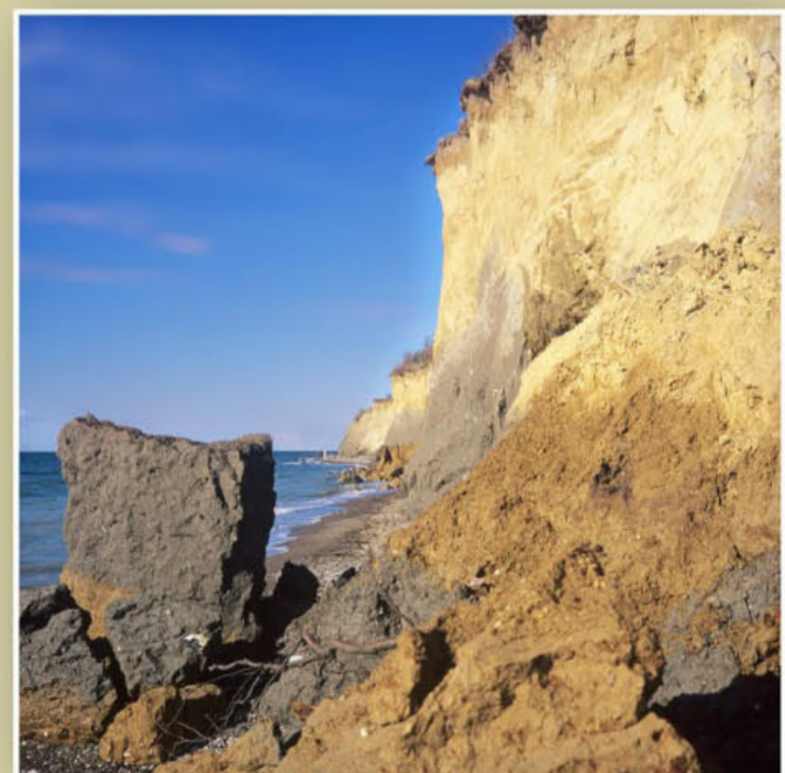
Abbrüche am Fischland-Hochufer (Mai 2009)
