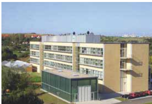
Laborgebäude der Hochschule Neubrandenburg
