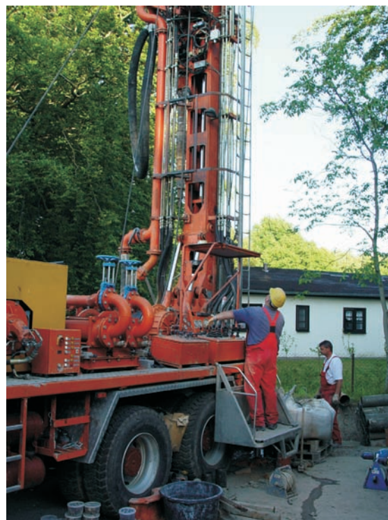
Abb. 9: Bohranlage im Einsatz
